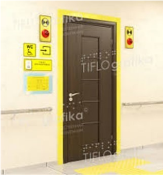
Fig. V.23. – Exemplu de conformare a suprafețelor vitrate în cadrul foi de ușă și realizarea contrastului vizual
