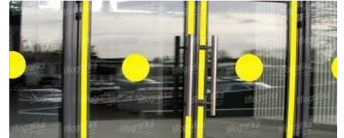
Fig. V.23. – Exemplu de conformare a suprafețelor vitrate în cadrul foii de ușă și realizarea contrastului vizual
