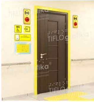
Fig. V.23. – Exemplu de conformare a suprafețelor vitrate în cadrul foii de ușă și realizarea contrastului vizual
