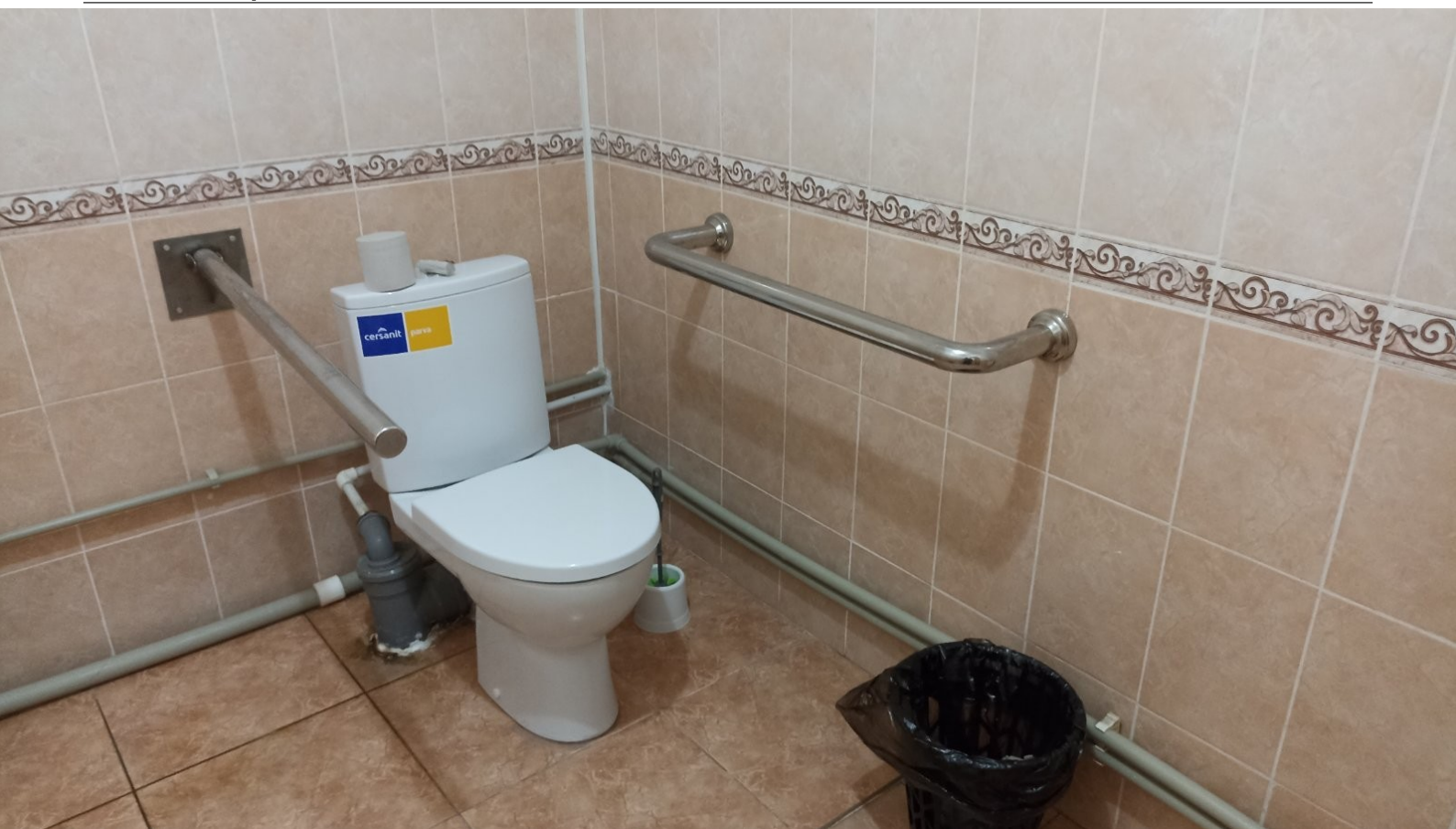
Galerie - Grup sanitar
